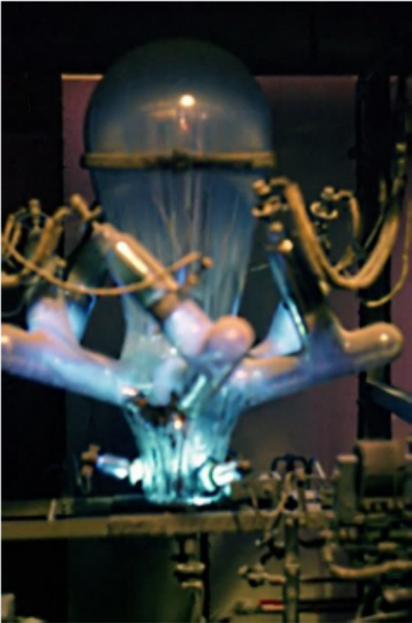
Prostownik rtęciowy rozdzielni Laboratorium Maszyn Elektrycznych w Gmachu Fizyki z lat 50 XX wieku
