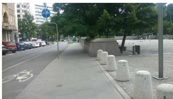
Fot. 4. Chodnik wzdłuż ul. Noakowskiego – brak dotykowo wyczuwalnego oznaczenia pomiędzy chodnikiem a ścieżką rowerową
