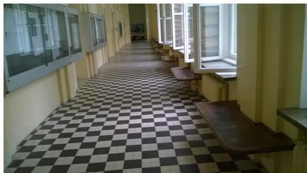
Fot. 12. Fragment korytarza na poziomie +1 – okna zabezpieczone przez ławki na stałe zamocowane do ścian
