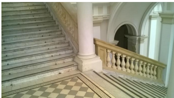
Fot. 9. Schody przy Auli, oznaczone krawędzie stopni schodów
