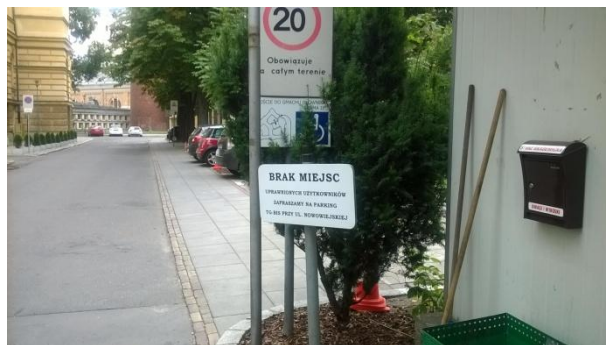
Fot. 22. Nieczytelna informacja o sposobie dotarcia do wejścia dostępnego dla osób poruszających się na wózkach inwalidzkich – informacja połączona ze znakami drogowymi i zasłonięta gałęziami
