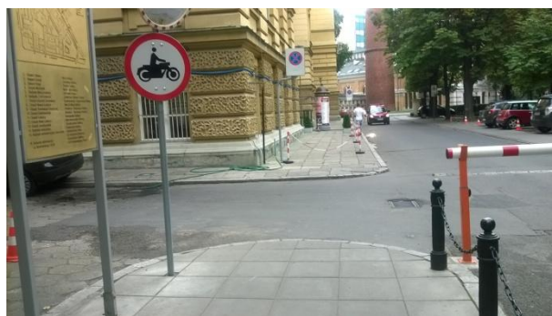
Fot. 6. Brama przy ul. Noakowskiego – zbyt nisko umieszczony znak B4 – „Zakaz wjazdu motorem”
