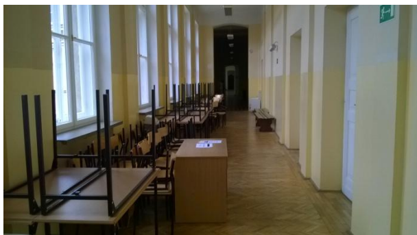
Fot. 13. Niepoprawne ustawienie mebli w trakcie prac remontowych – biurko wystaje poza linię pozostałych mebli
