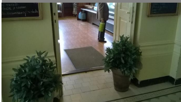
Fot. 19. Bar – donica w świetle drzwi ogranicza szerokość przejścia, stanowiąc przeszkodę dla osób poruszających się na wózkach inwalidzkich
