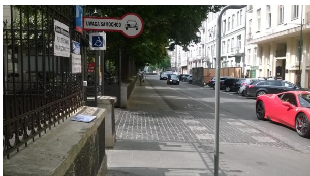
Fot. 3. Chodnik wzdłuż ul. Noakowskiego – zbyt nisko umieszczony znak „Uwaga samochód”, brak dotykowo wyczuwalnego oznaczenia pomiędzy chodnikiem a ścieżką rowerową
