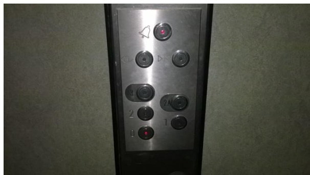
Fot. 8. Dźwig osobowy przy bibliotece – panel sterujący z niepotrzebnie wyróżnionymi dotykowo klawiszami poziomów 2a i 3
