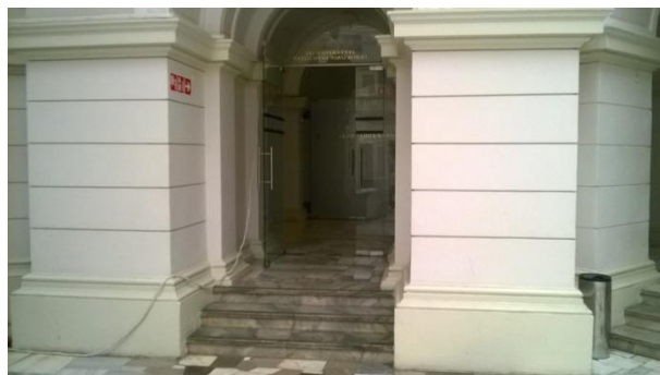
Fot. 10. Niedostępne dla osób poruszających się na wózkach inwalidzkich wejście do Klubu Absolwenta. Proponowana lokalizacja dodatkowej pochylni
