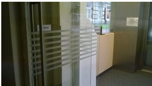
Fot. 21. Drzwi do windy – mało czytelne oznakowanie szklanej tafli w kolorze piaskowanego szkła
