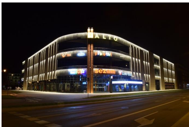
Rys. 1.20. Iluminacja galerii handlowej na warszawskim Wilanowie, jak przykład odwrócenia typowego kierunku oświetlenia w iluminacji obiektów – oświetlenie „górną-dół”
