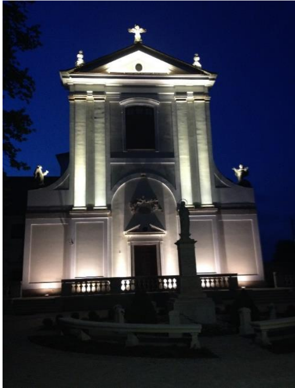
Rys. 3.6. Zdjęcie porealizacyjne iluminacji kościoła Poreformackiego w Węgrowie (fot. Krzysztof Skarżyński)[44]
