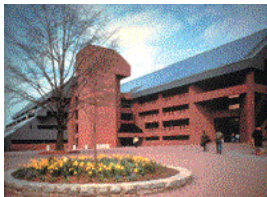
Rys. 3.8. Georgetown University. System jest dołączony do sieci i składa się z 4464 modułów firmy Solarex. Jego moc szczytowa wynosi 337 kWp.
