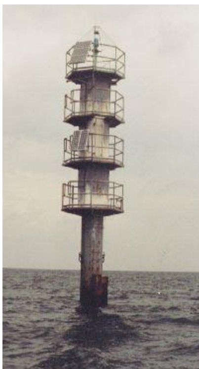
Rys. 3.17. System zasilający platformę na Bałtyku.
