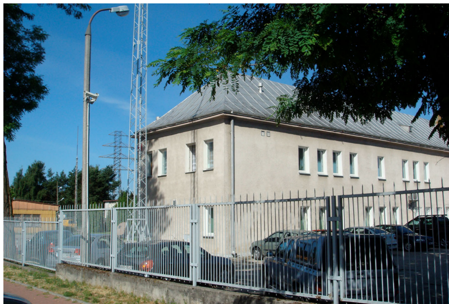
Rys. 10. Nowy budynek Rejonu Energetycznego w Wołominie
