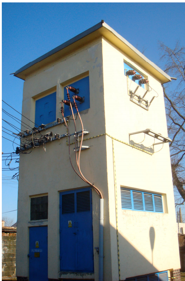
Rys. 8. Wieżowa stacja transformatorowa (nie istniejąca już)
