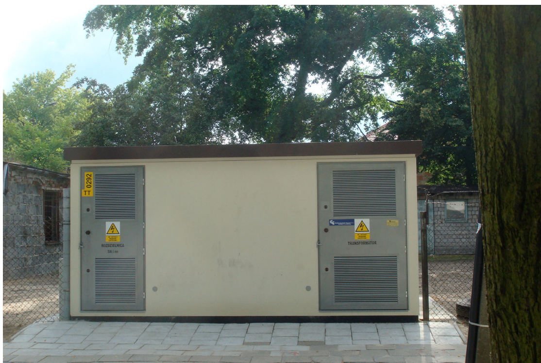
Rys. 9. Istniejąca obecnie kompaktowa stacja transformatorowa
